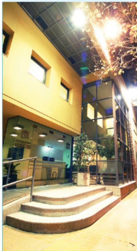
Edificio Sanatorio argentino
